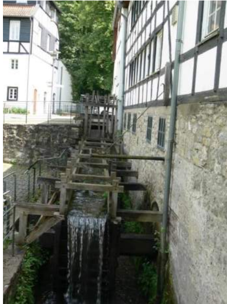
1 pav. Rekonstruotas Senojo Dombacho malūno griovys
